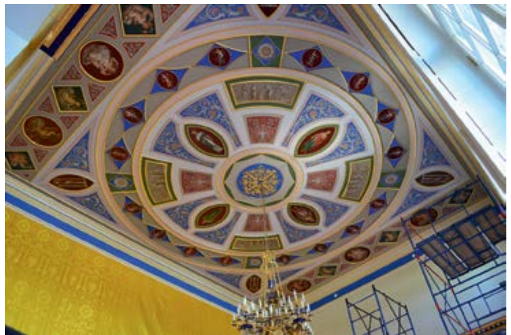
Ил. 8. Общий вид плафона после завершения работ Fig. 8. General view of the plafond after the restoration
