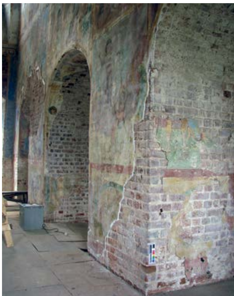
Ил. 8. Участок после инъектирования и удаления фиксационных поджимов Fig. 8. The Mural after the injection and clamps removal
