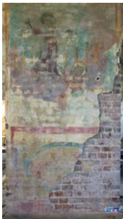
Ил. 7. Участок после инъектирования и удаления фиксационных поджимов Fig. 7. The mural detail after the injection and clamps removal
