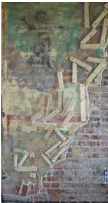
Ил. 6. Фиксация штукатурного пласта с помощью поджимных реек Fig. 6. Fixation of the plaster layer with clamps
