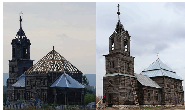
Ил. 11. Процесс устройства консервационной кровли на церкви Михаила Архангела в с. Павловка, 2025 г. Fig. 11. Installing a conservation roof over the Church of Saint Michael the Archangel in the village of Pavlovka, 2025.
