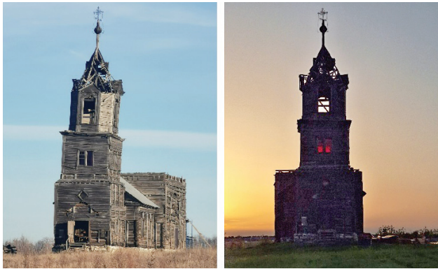
Ил. 9. Выправление наклона колокольни церкви Михаила Архангела в с. Павловка, 2025 г. Fig. 9. Straightening the lean of the bell tower of the Church of Saint Michael the Archangel in the village of Pavlovka, 2025.
